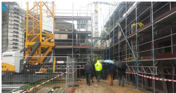
Neubau der Werkstatt der KBS Elmshorn
