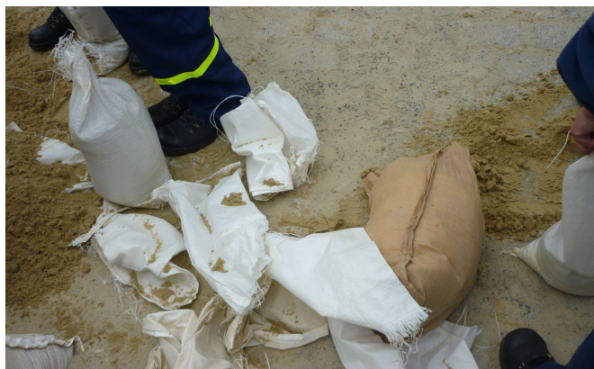
Sandsäcke werden befüllt
