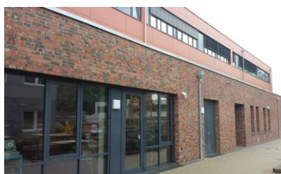
Der fertige, neue 1. Bauabschnitt der Kreisberufsschule Pinneberg
