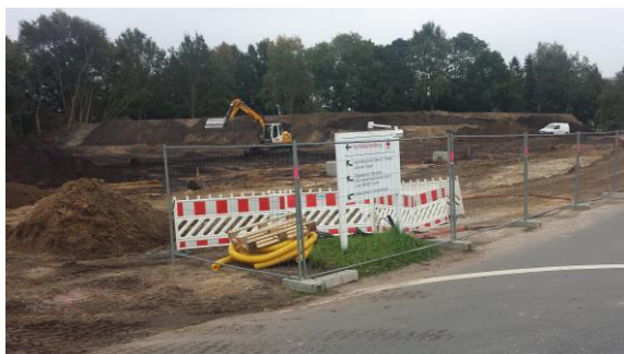
Die Bagger rollen schon für die neue Regionalleitstelle West in Elmshorn
